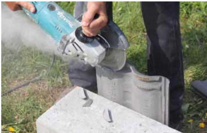
Einmal kurz angesetzt, schon ist der Ziegel gefräst, um dem Dachhaken später genug Luft zu geben.
